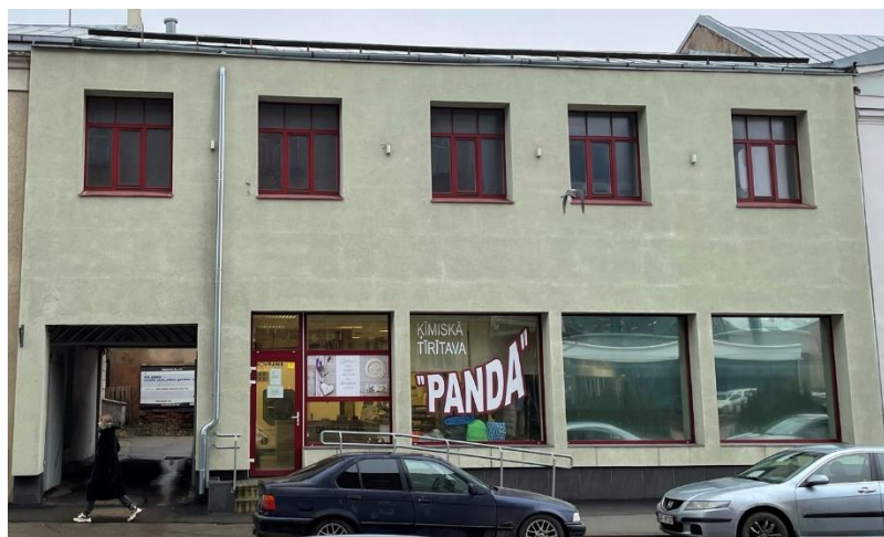
4.13.1.1. attēls. PVC logi un vitrīnas – ēkas galvenā fasāde
