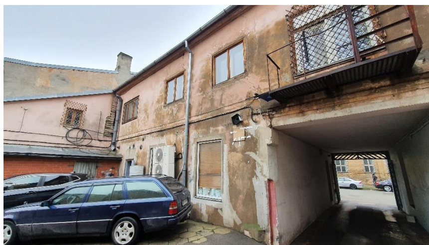
4.2.3.4. attēls. Ēkas pagalma fasāde
