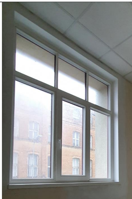
4.13.1.5. attēls. PVC logs – 2. stāvs, telpa Nr. 9
