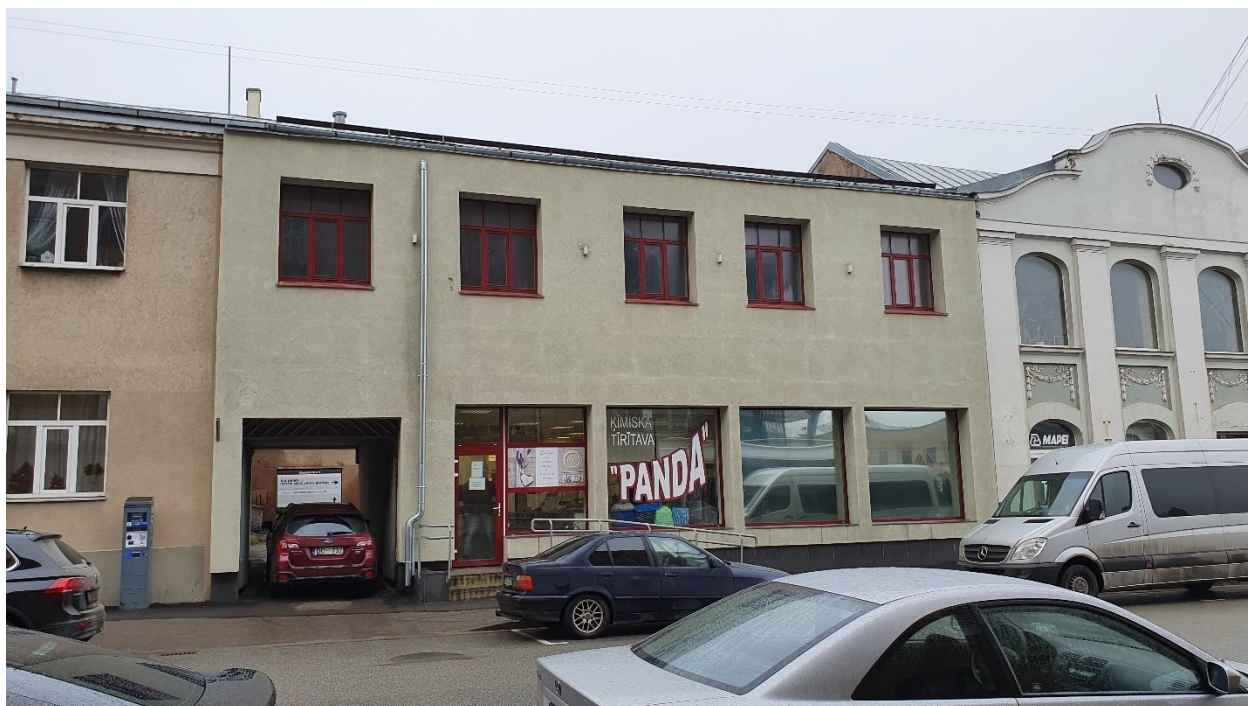
1. attēls. Veikals Tērbatas ielā 76, Rīgā
