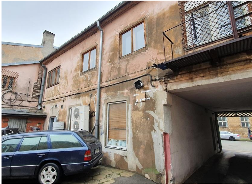
5.6.1.4.attēls. Ventilācijas restes uz pagalmu fasādes
