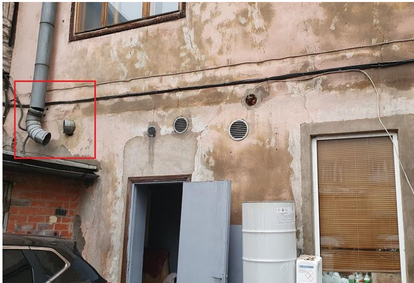
5.6.1.5.attēls. Nosūces gaisa vads ir atvienots no vertikāla stāvvada
