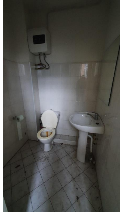
4.18.1.5. attēls. Flīzes, krāsots apmetums, piekārtie griesti – 2. stāvs telpa Nr. 6
