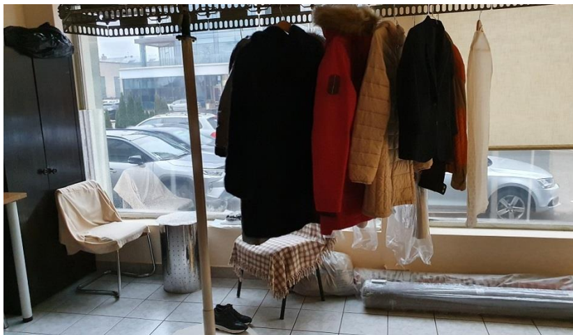
5.5.1.2.attēls. 1.stāva telpas bez apkures sildķermeņiem
