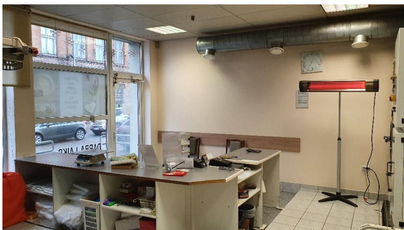
4.18.1.2 .attēls. Krāsotas tapetes, piekārtie griesti – 1. stāvs, telpa Nr. 1
