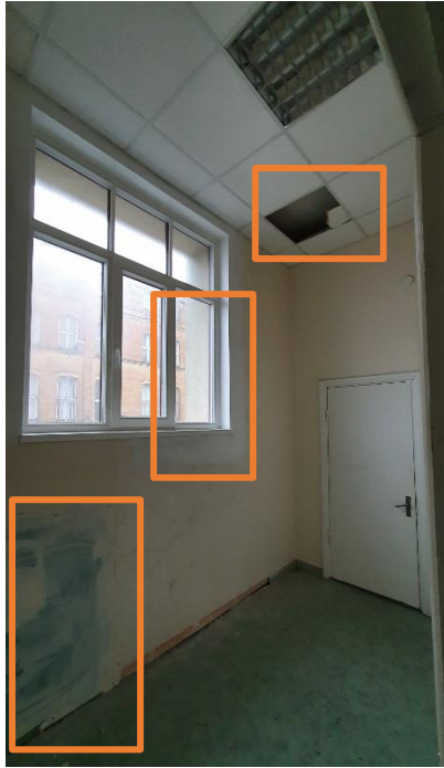
4.18.1.4 .attēls. Krāsots apmetums, piekārtie griesti – 2. stāvs, telpa Nr. 9
