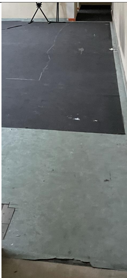
4.12.1.4. attēls. Linoleja grīdas segums (2. stāvs, telpa Nr. 5)
