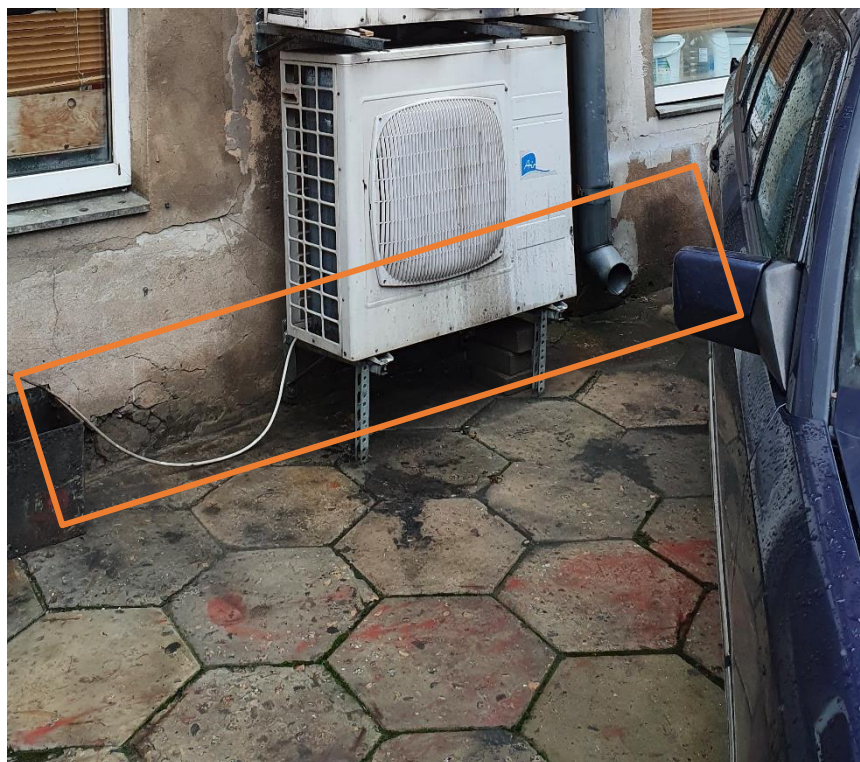
4.1.2.1. attēls. Mitrums un mitruma radīti bojājumi uz nesošās ār sienas
