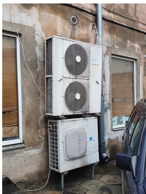
5.6.1.9.attēls. Dzesēšanas ārējie bloki piekarināti pie pagalmu fasādes
